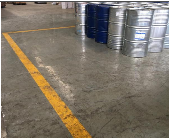
成品储存地面防腐防渗
