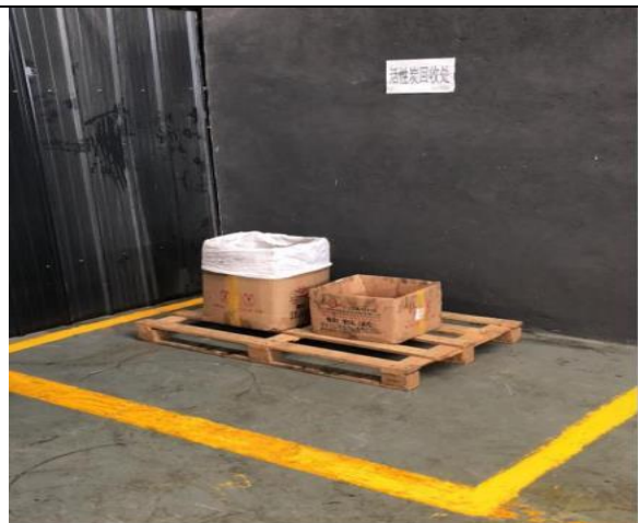
危险废物暂存区域地面防腐防渗
