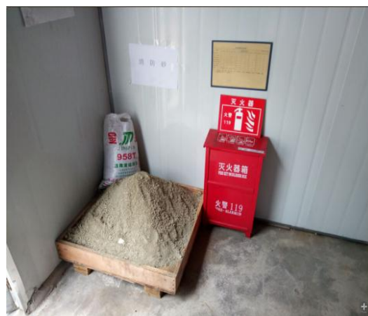
图 3-2 消防器材和消防砂
