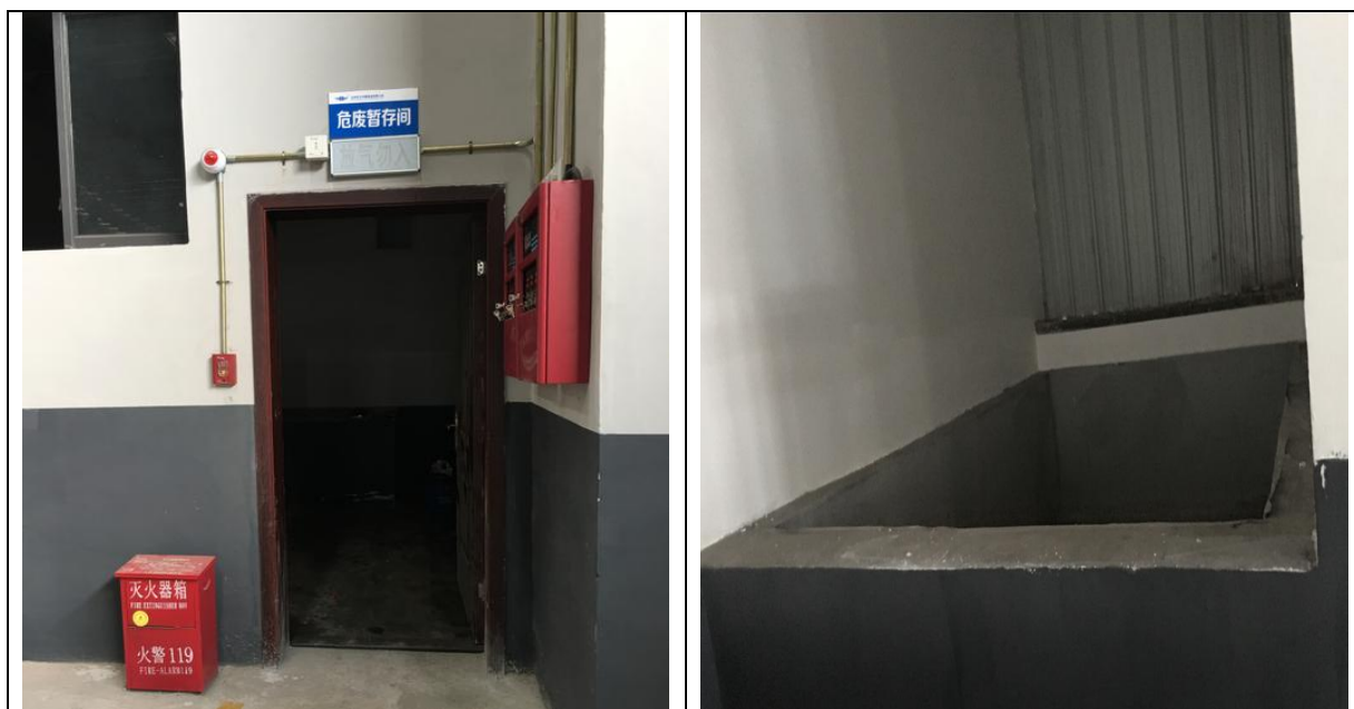
图3-2 本项目危险废物暂存间
