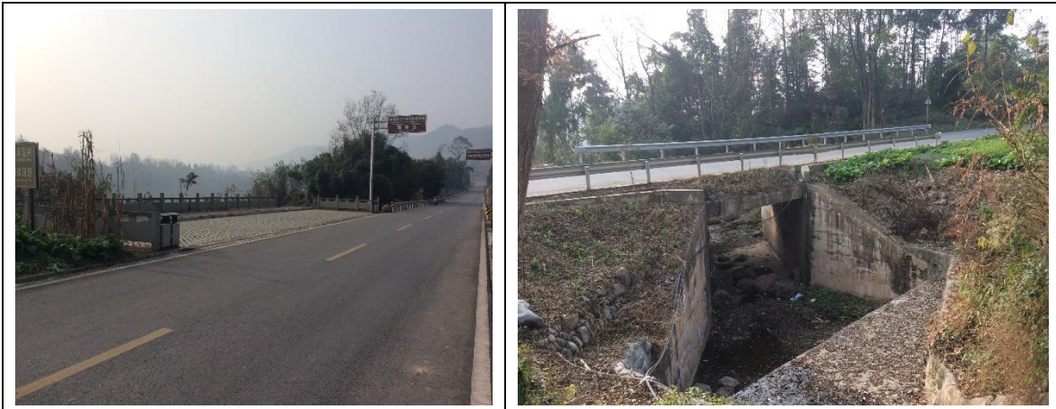
图 4-2 道路及桥梁现状图
