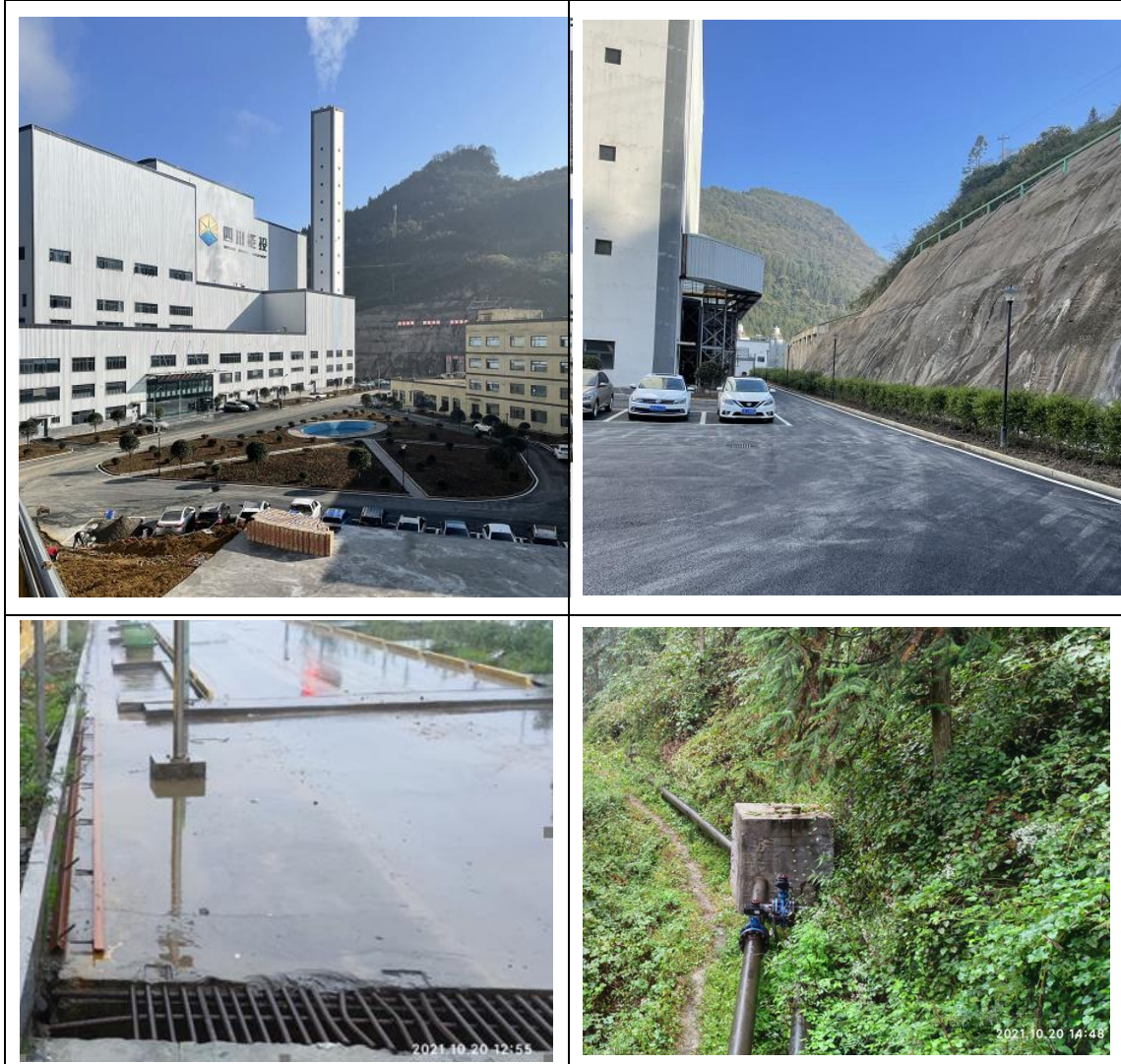
图 3.5-2 项目现场实地勘察情况
