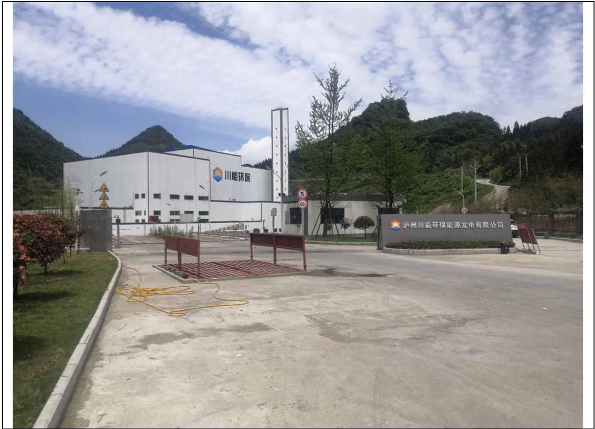
古叙生活垃圾焚烧发电项目现场检查照片
